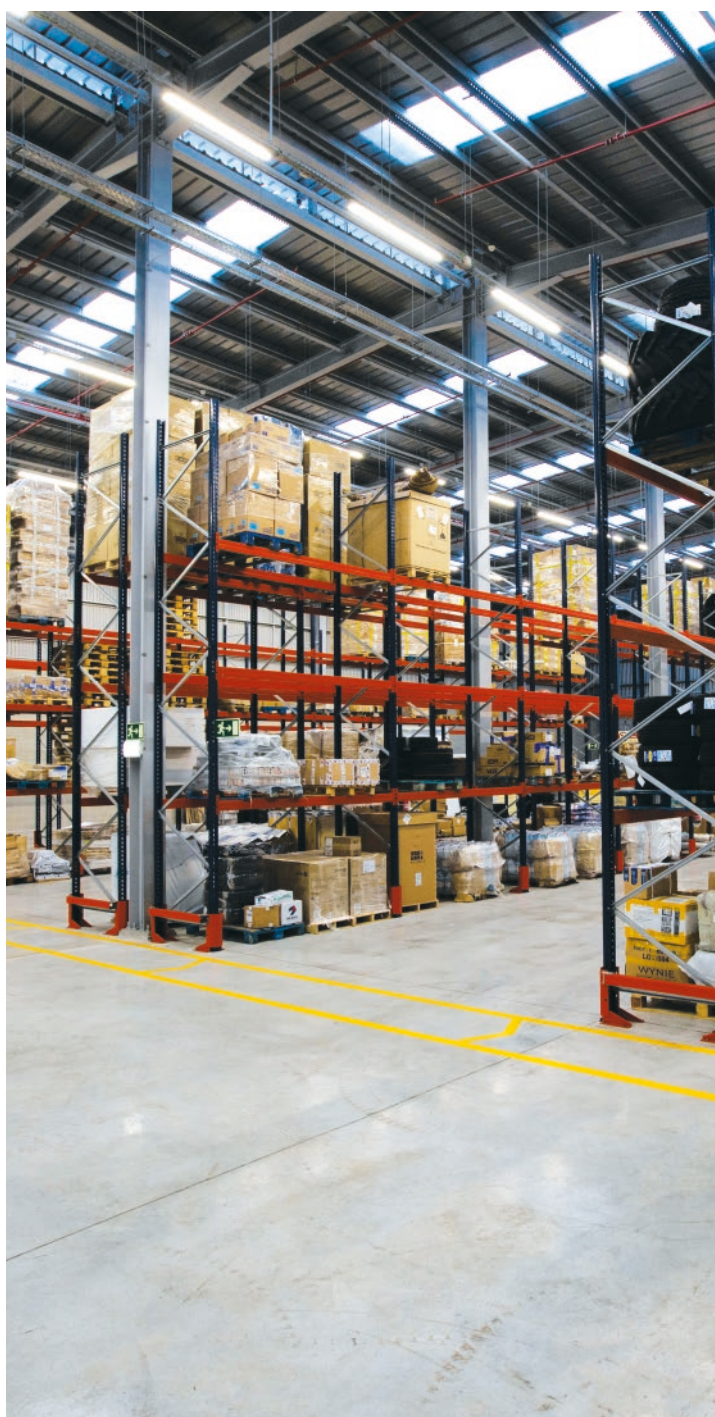
Armazéns ETE em Ponta Delgada, Açores.
