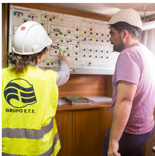
Superintendência de Navios, S&C, GRUPO ETE. Ship Oversight, S&C, GRUPO ETE.
