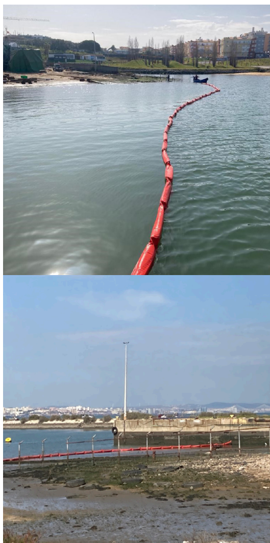
Barreira de contenção/prevenção de poluição do meio hídrico no Estaleiro da Navaltagus, Seixal, 2022. Barrier to contain/prevent water pollution at the Navaltagus Shipyard, Seixal, 2022.
